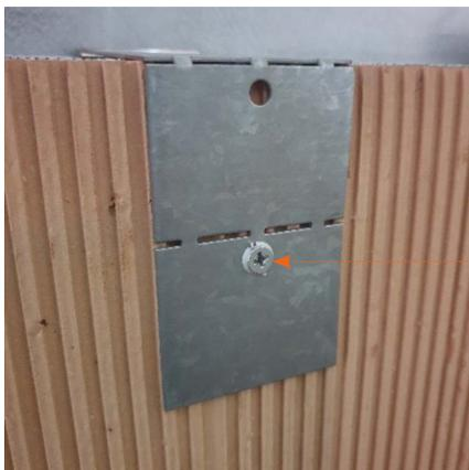
Verbindung zur Verwendung in Kombination mit Kalksandstein und Verbindung zur Verwendung in Kombination mit Schnellbauziegeln.
